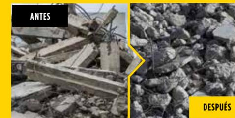
Las unidades MB CRUSHER transforman el material de desecho directamente en la obra y permiten de gestionar la recuperación y el reciclaje del material de manera completamente autónoma.
